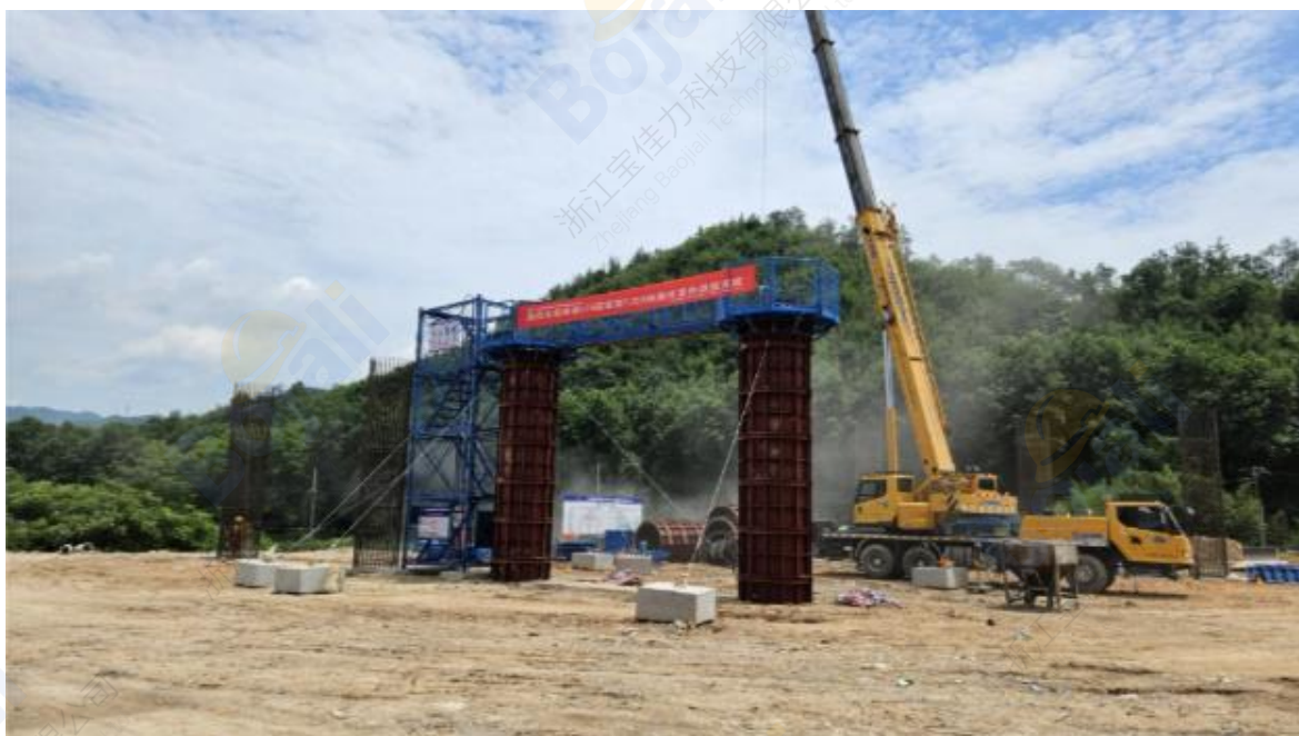
图 1 装配式盖梁施工平台现场应用
