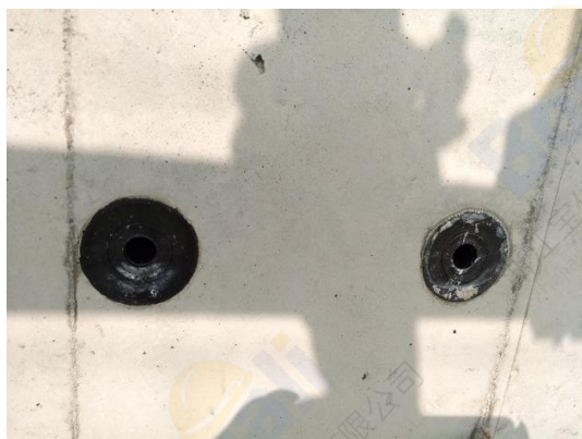
扭出安装螺杆，外侧模板拆除后，露出预埋件
