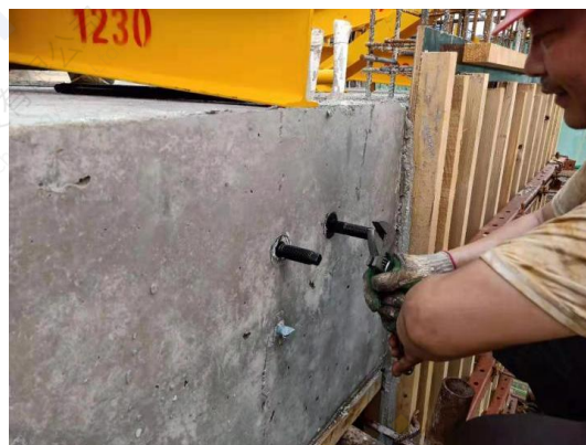
安装 S8.8 级、M20*225mm 长的高强“双头螺杆”
