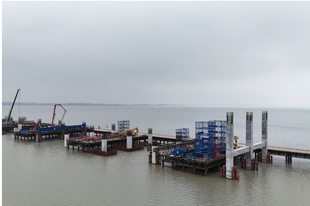
霍邱城东湖特大桥
