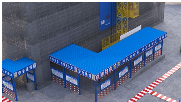
施工电梯防护棚
