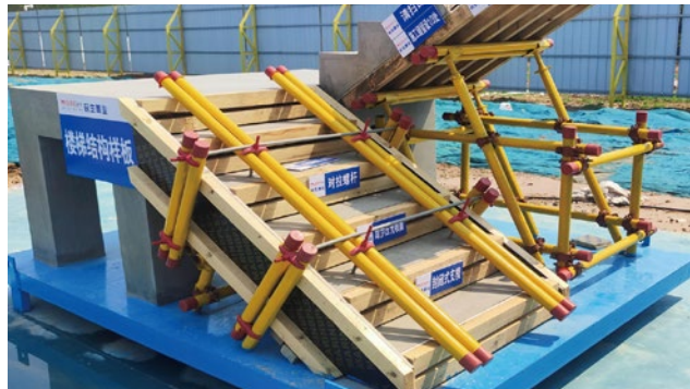
楼梯结构样板
