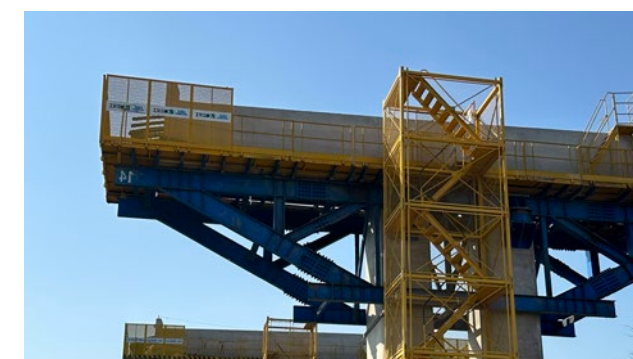
盖梁平台 & 安全梯笼
