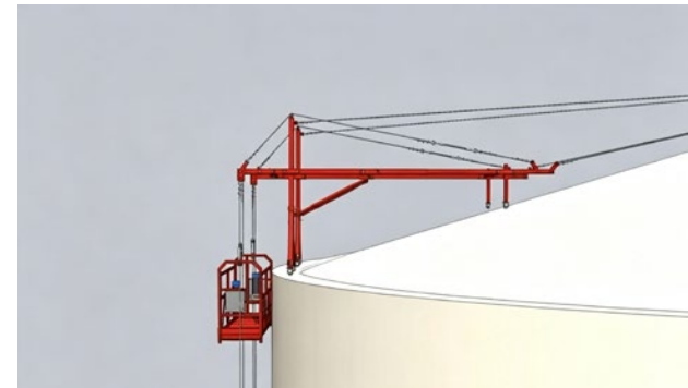
油罐外壁施工旋转电动吊篮
