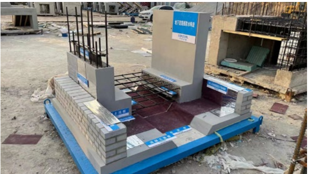
地下室结构样板
