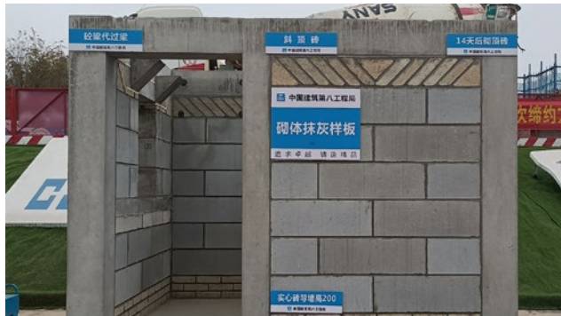
砌体抹灰样板
