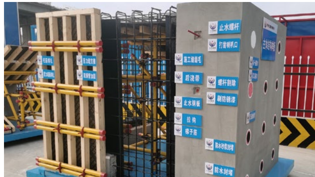
主体结构样板
