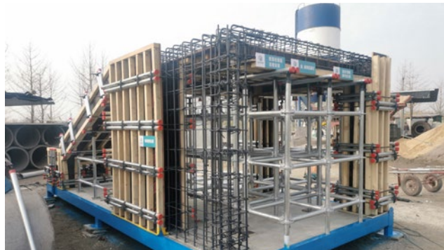
木工综合质量样板
