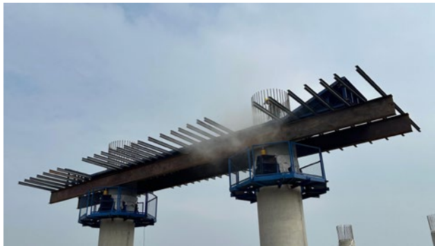
墩柱抱箍平台
