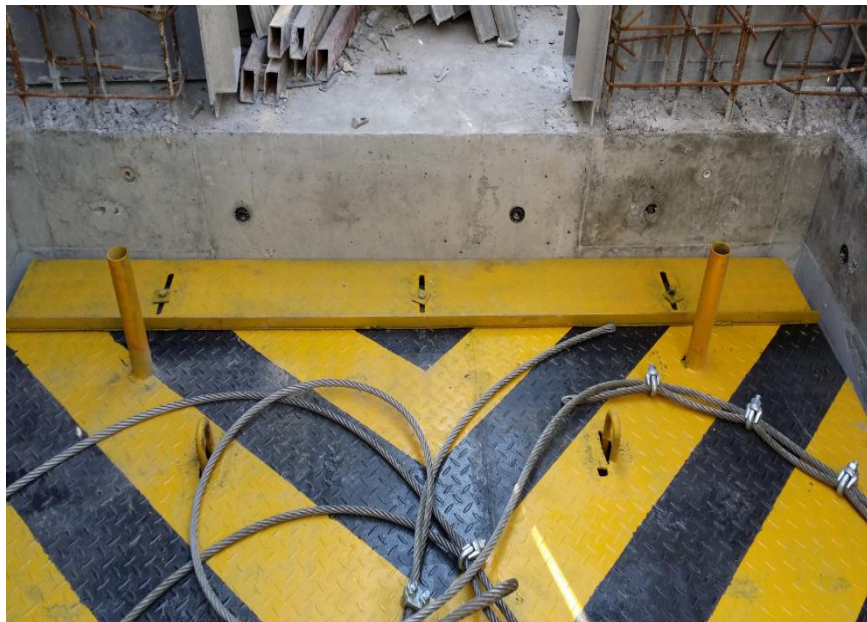
图6.3-1 电梯井钢施工平台现场俯视图
