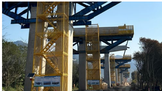
沈海高速扩建
