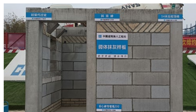
砌体抹灰样板
