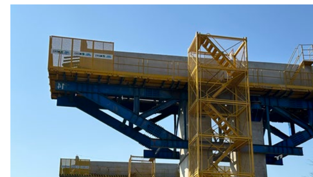
盖梁平台 & 安全梯笼
