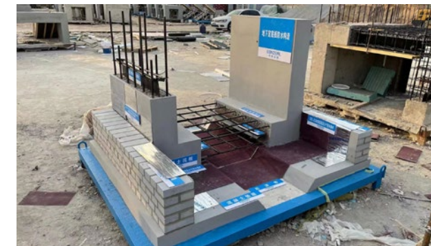
地下室结构样板
