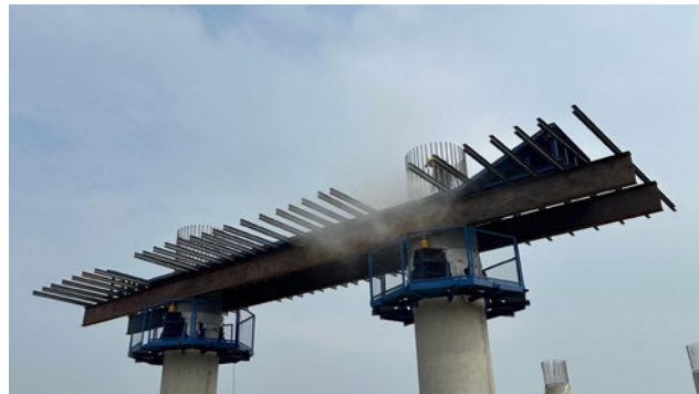
墩柱抱箍平台
