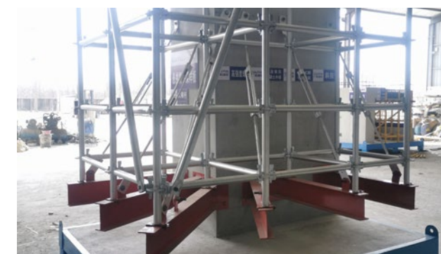
花篮悬挑脚手架样板
