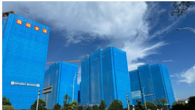
中交义乌安置房项目
