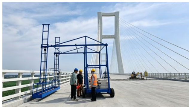
桥梁外侧施工台车
