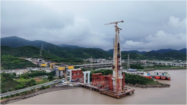
金塘海底隧道
