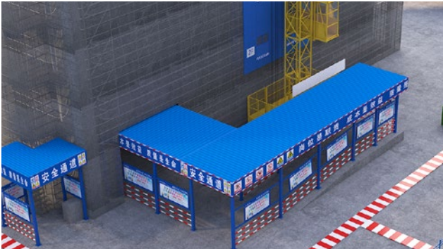
施工电梯防护棚
