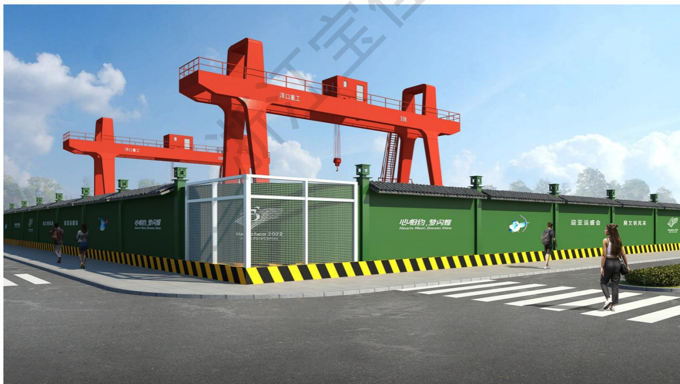
市政基础设施工程围挡（新标准 3m）
