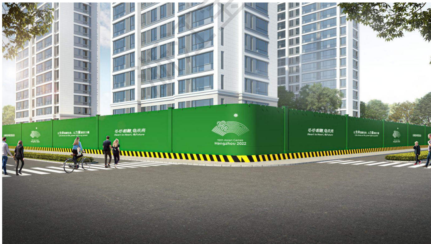
房屋建筑工程围挡（新标准 4m）
