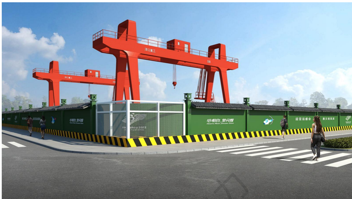
市政基础设施工程围挡（旧标准 2.1m）
