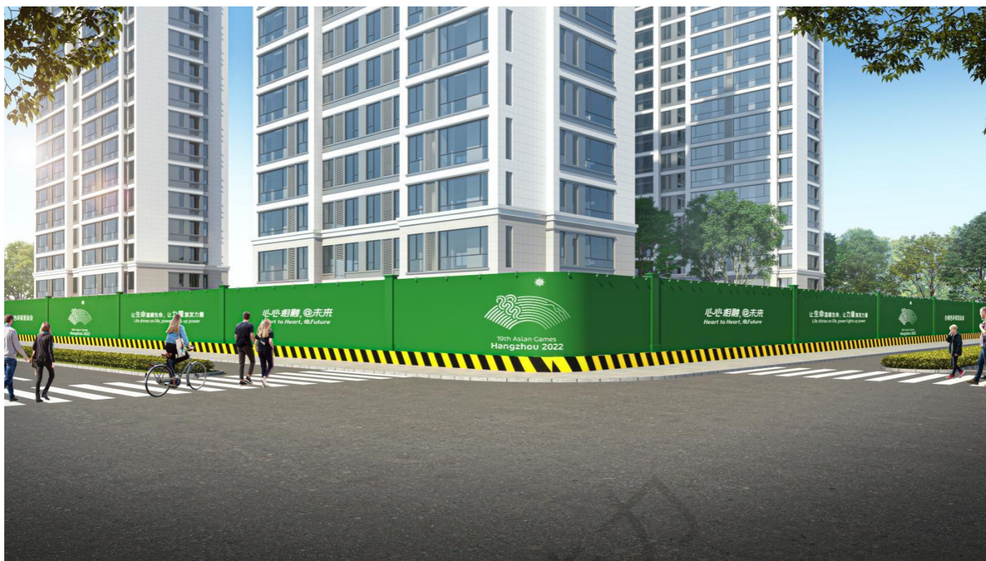
房屋建筑工程围挡（旧标准 2.5m）
