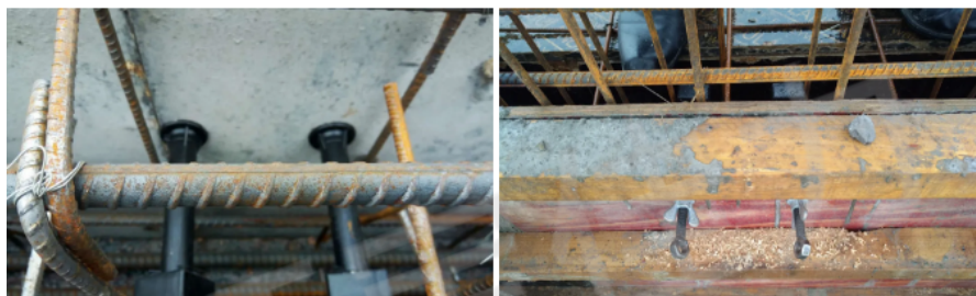
电钻打孔预埋，无需拉线接电
