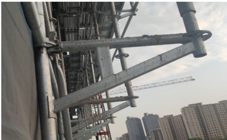
悬挑架底部采用硬质封底防护。
