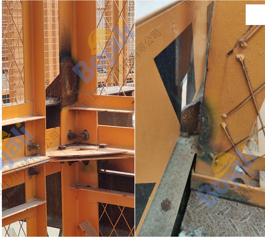
图 4.5-3 梯笼螺栓、焊接连接示意图
