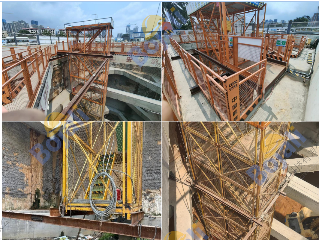
图 4.5-2 梯笼与各道砼支撑连接示意图
